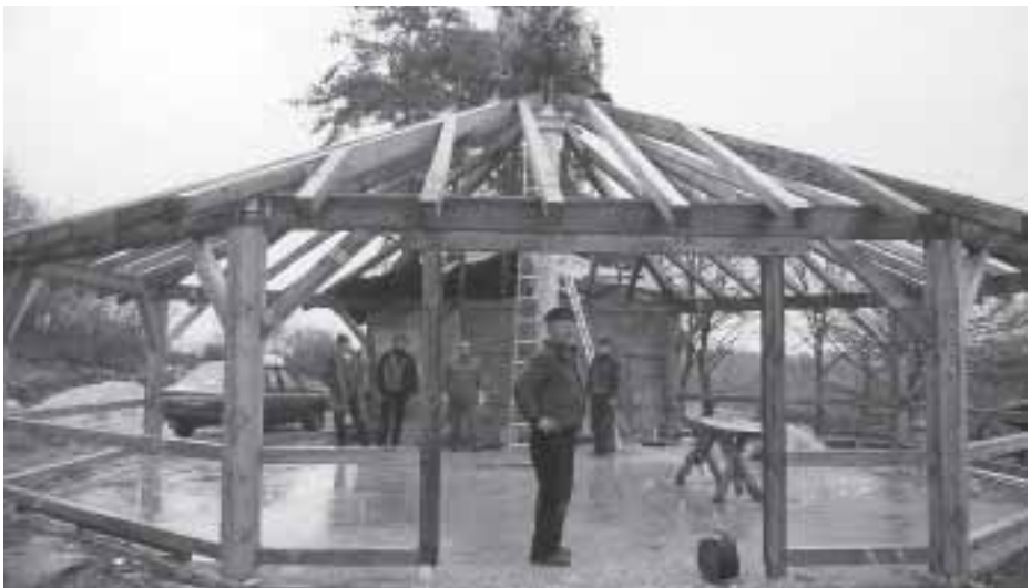
Sangesbruder Walter Hartmann beim Richtfest der Schutzhütte
